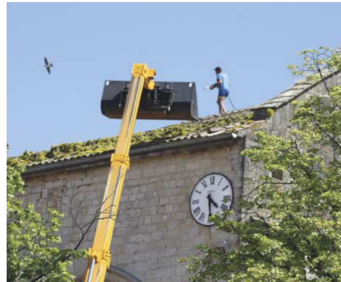
Nettoyage de la toiture de l'église qui nécessite du professionnalisme pour mener à bien le chantier
