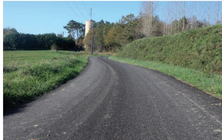
La commune a refait en enrobé à froid la route de Lasserre à Routges et Peyrouat (4 km) et la route de Papon au château d'eau d'Arquizan (2,5 km) pour un total de 120 000 € HT, auxquels s'ajoutent 20 000 € HT de réparations effectuées sur les autres routes montréalaises.
